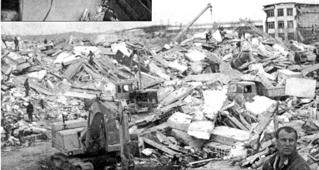
1995 г. Дальневосточный РЦ. Нефтегорск
