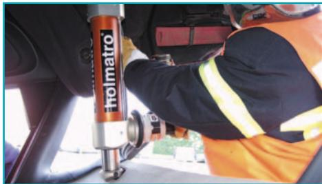
Установите домкрат на надежную опорную поверхность на крыше автомобиля и создайте домкратом усилие между крышей и полом автомобиля.
