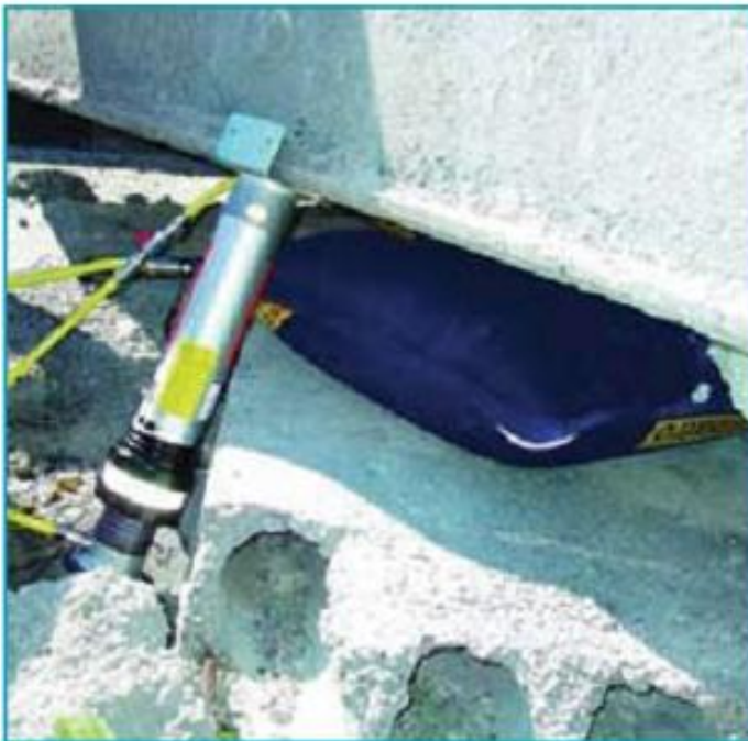
Страховочная распорка , использованная при работе подъёмной подушки
